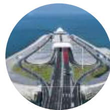
大桥香港口岸 (香港人工岛)
